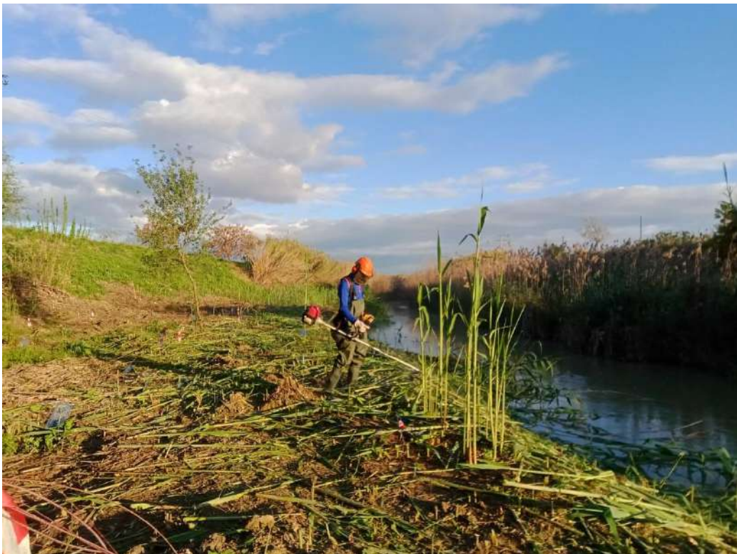
Imagen 4. Tareas de mantenimiento en la curva de Nonduermas
