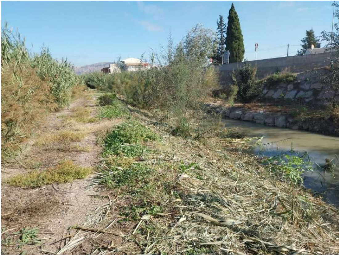
Imagen 15. Estado tras desbroce veraniego en El Raal
